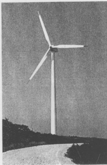
Fig. 11. Parque eólico de Sotavento.
